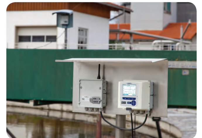
Optymalny pomiar poziomu osadu przy pomocy systemu 282/284 z komunikacją radiową
