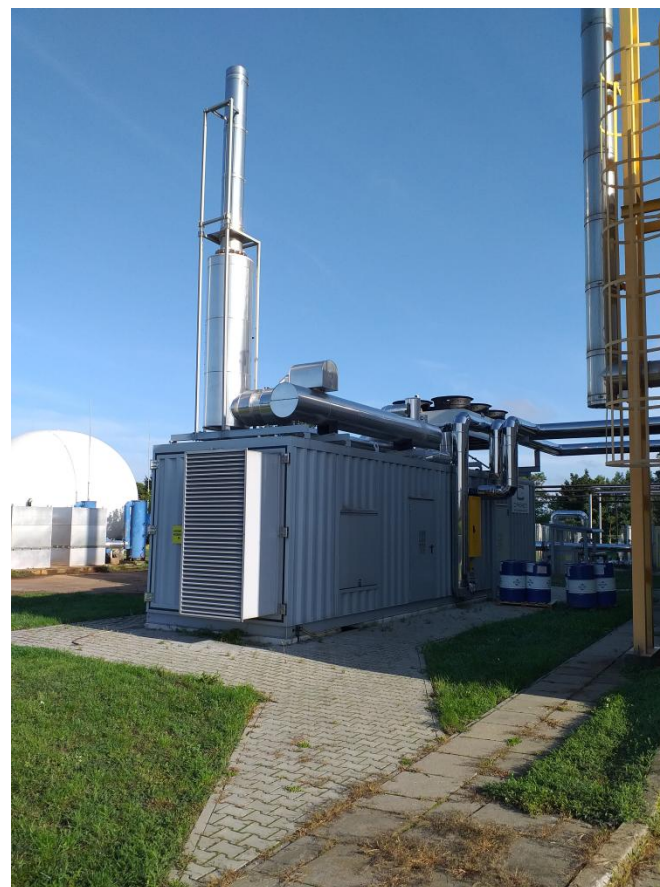
Kanał obejścia (przelew burzowy) i agregat kogeneracyjny BTCK 1200 kW
