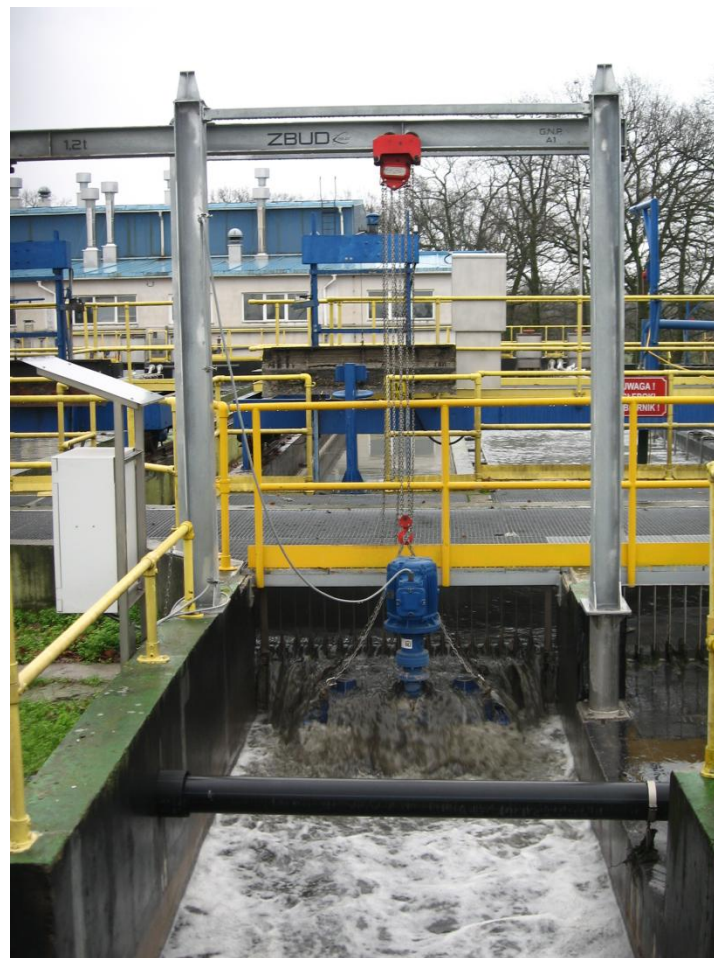
Punkt przyjmowania odpadów z czyszczenia sieci kanalizacyjnej i rozdrabniacz kanałowy
