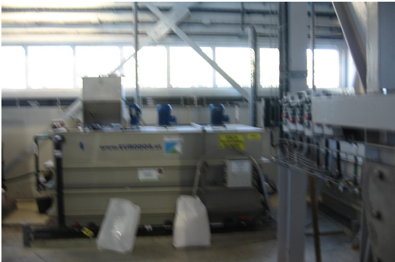
Stacja przygotowania roztworu polielektrolitu ( proszek, emulsja )
