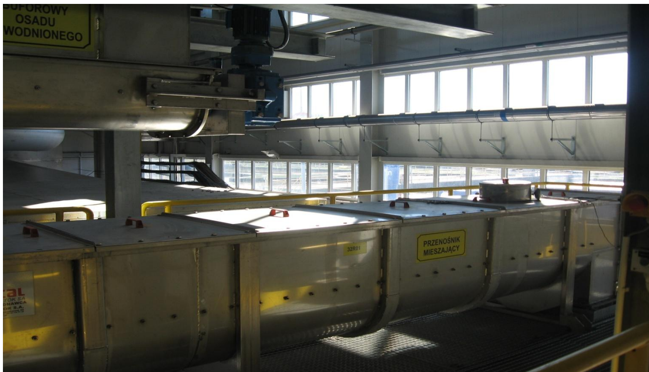
Mieszacz ślimakowo – łopatkowy osadu wysuszonego z osadem odwodnionym
