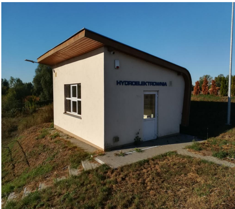
Budynek hydroelektrowni i turbina
