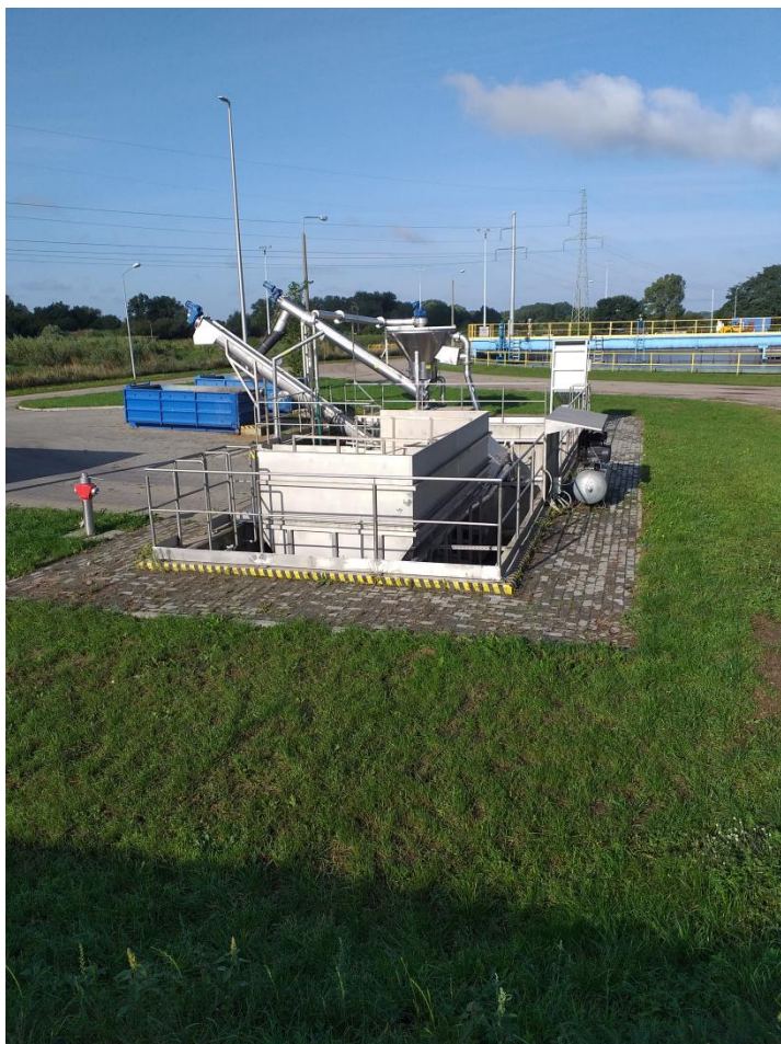
Punkt przyjmowania odpadów z czyszczenia sieci kanalizacyjnej i rozdrabniacz kanałowy
