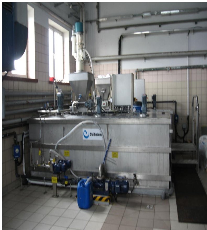
Stacja polimeru i zagęszczarki
