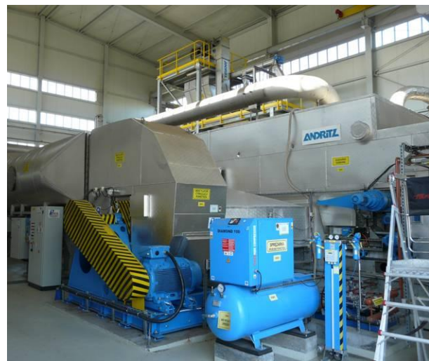
Budynek stacji termicznej przeróbki osadu, korpus suszarni, palnik z wentylatorem cyrkulacyjnym
