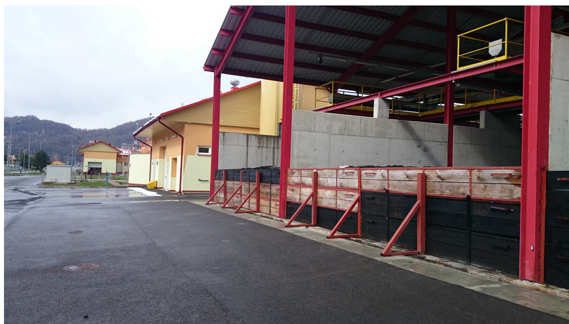
Rys. nr 8. Widok na budynek prasy taśmowej i magazyn osadu.
