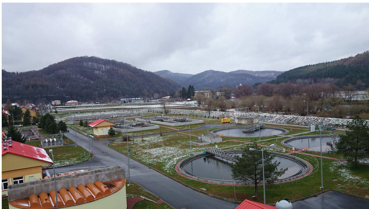
Rys. nr 2. Widok na reaktory biologiczne i osadniki wtórne.
