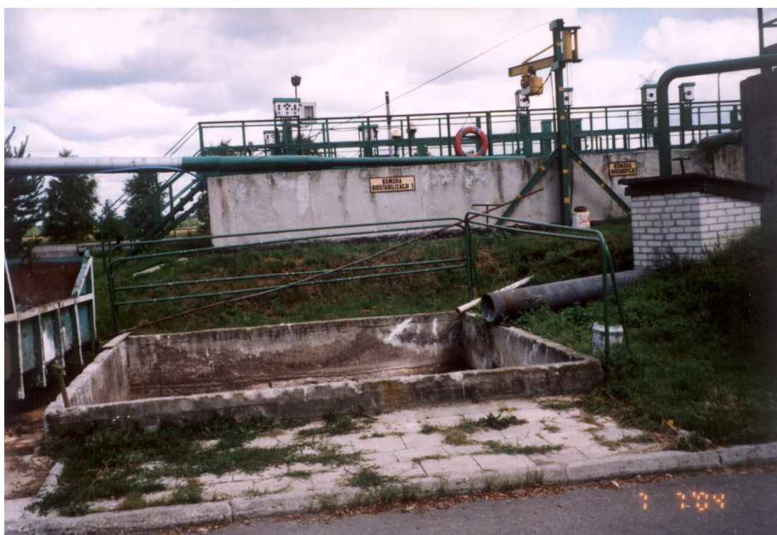
Fot. 4. Widok na piaskowni wraz z poletkiem na piasek oraz komory biosorpcji i biostabilizacji Oczyszczalnia Ścieków w Długiej Kościelnej, sierpień 2004 r.
