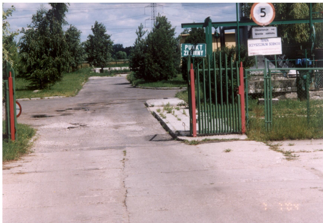
Fot. 1. Brama główna, wjazd na Oczyszczalnię Ścieków w Długiej Kościelnej, sierpień 2004 r.
