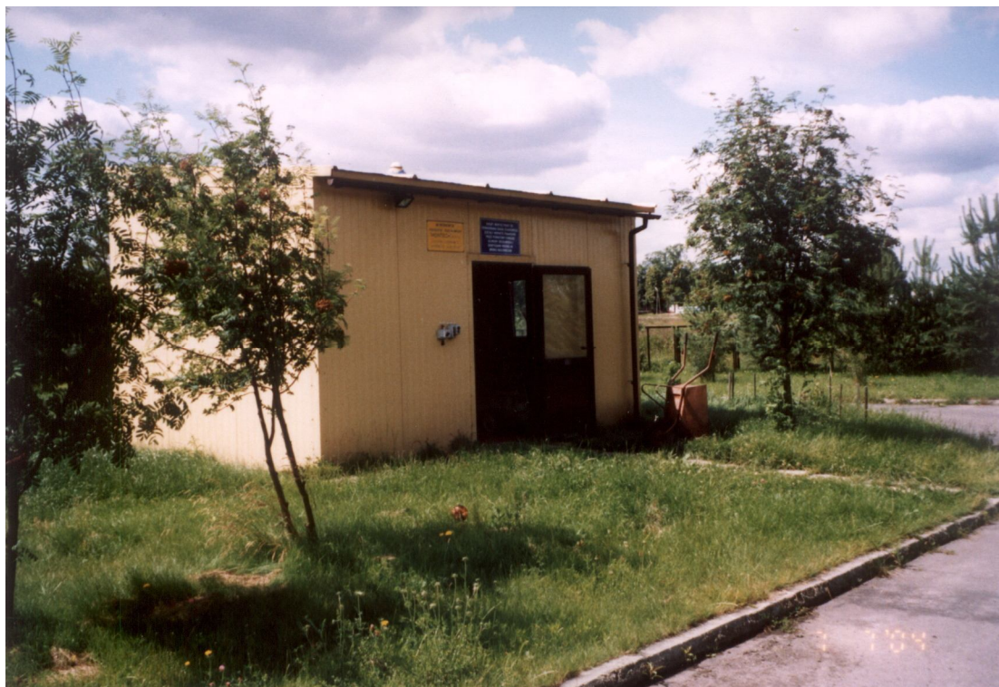
Fot. 7. Widok na budynek kontenerowy w środku prasa komorowa, Oczyszczalnia Ścieków w Długiej Kościelnej, sierpień 2004 r.
