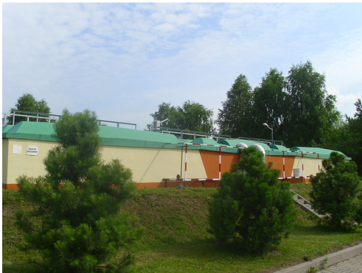
Fot. 13. Komora beztlenowa i komory niedotlenione Oczyszczalnia Ścieków w Długiej Kościelnej, czerwiec 2013 roku.
