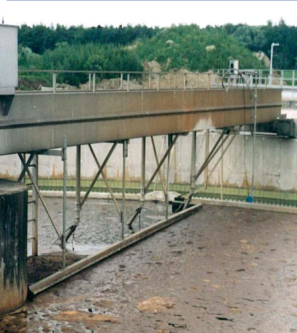
Przed i po instalacji pływającego zgarniacza SSR
