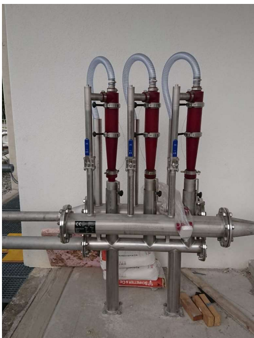
Na zdjęciu powyżej widoczny zestaw hydrocyklonów 3 x 10m 3 /h
