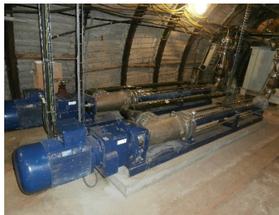
Kopalnia Soli Wieliczka Medium: ścieki bytowe H_{geom} = 260 m L = 310 m
