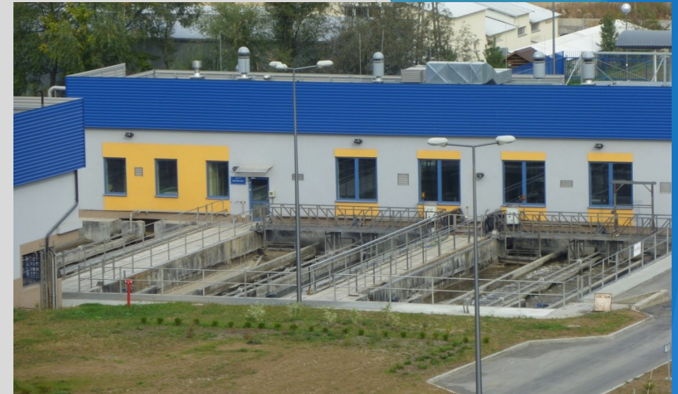
Budynek krat i piaskowniki
