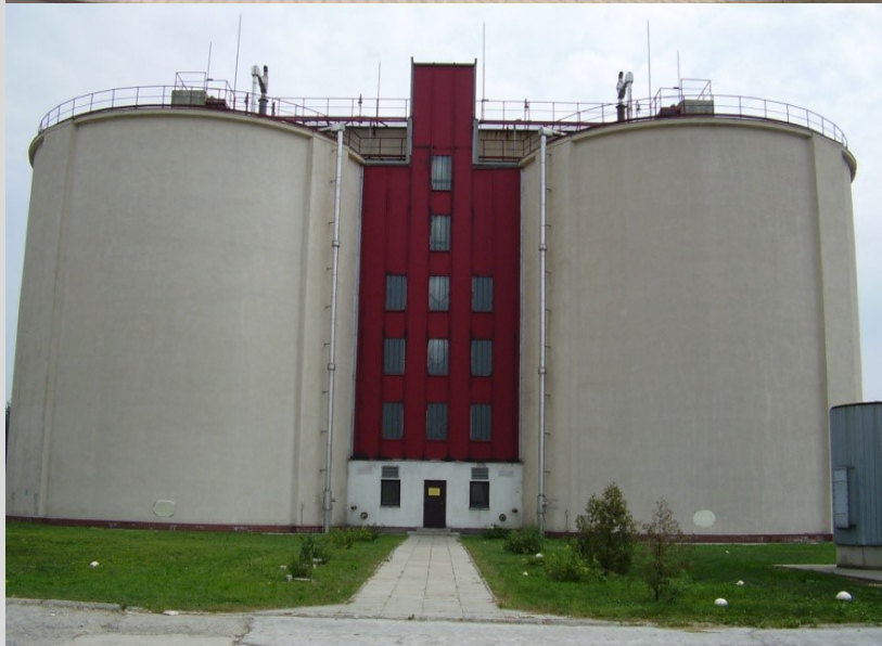
Wydzielone Komory Fermentacyjne
