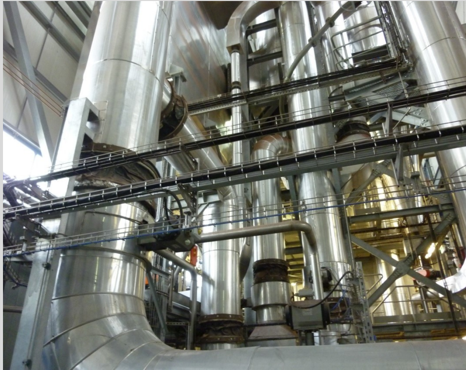
Stacja Termicznej Utylizacji Osadów Ściekowych
