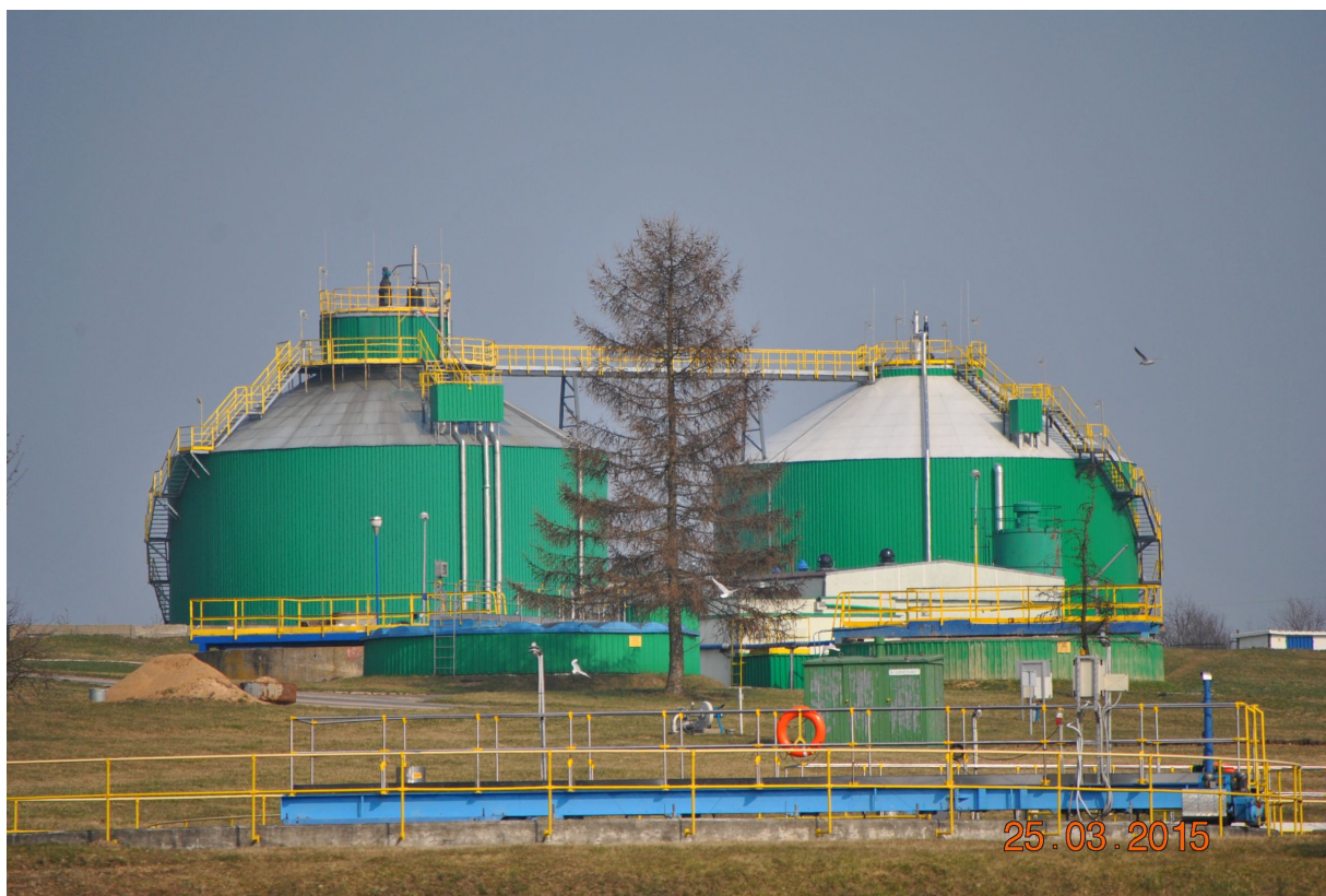
Fot. 1. PWiK Ostróda Sp. z o.o. Oczyszczalnia ścieków w Tyrowie – zbiorniki ZKF.
