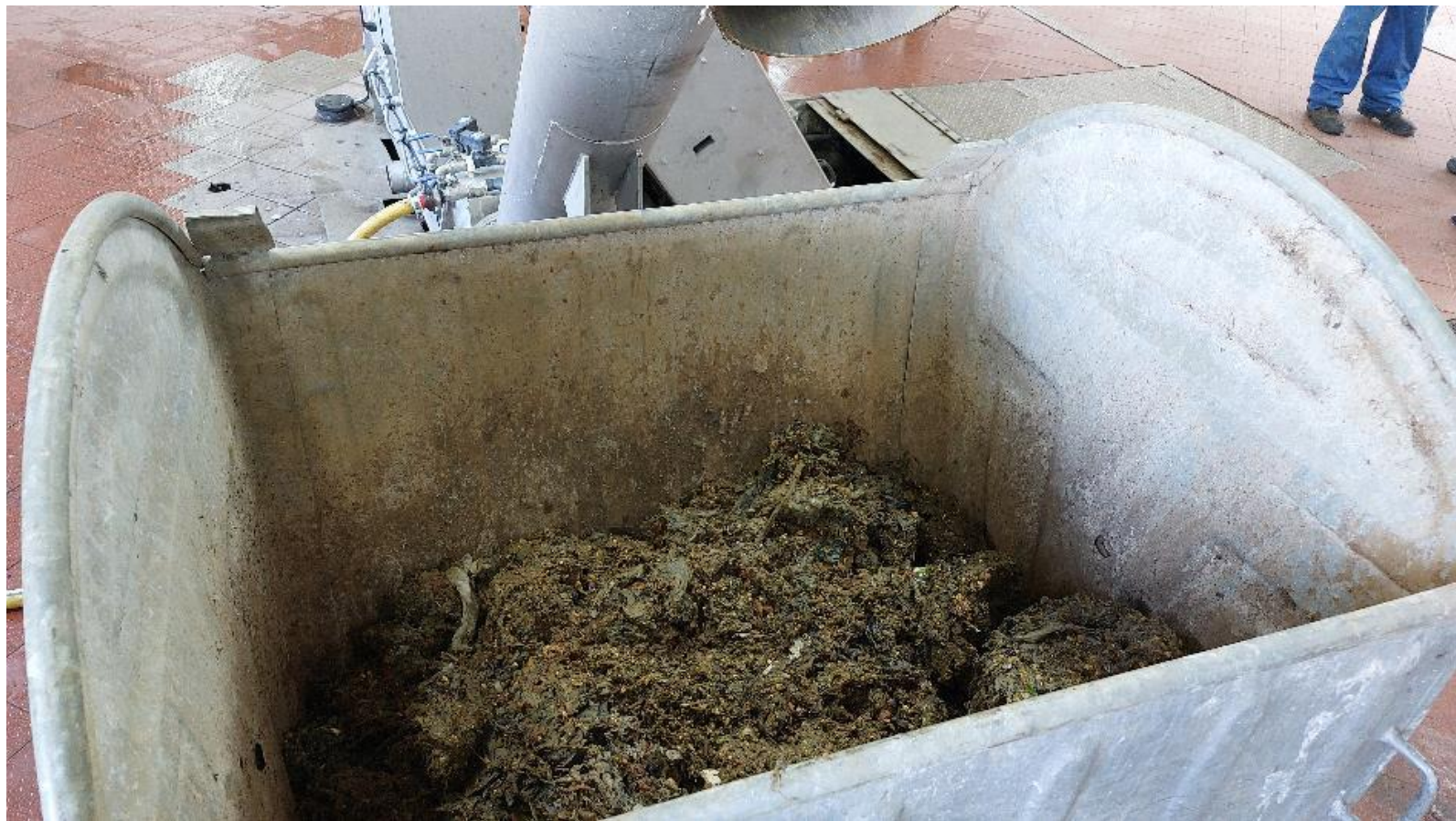
Pojemnik z skratkami po płuczce w hali krat na oczyszczalni ścieków w Bolesławcu – 04-04-2024
