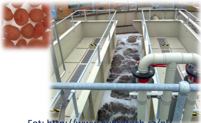
Bioreaktory z granulowaną biomasą anammox
