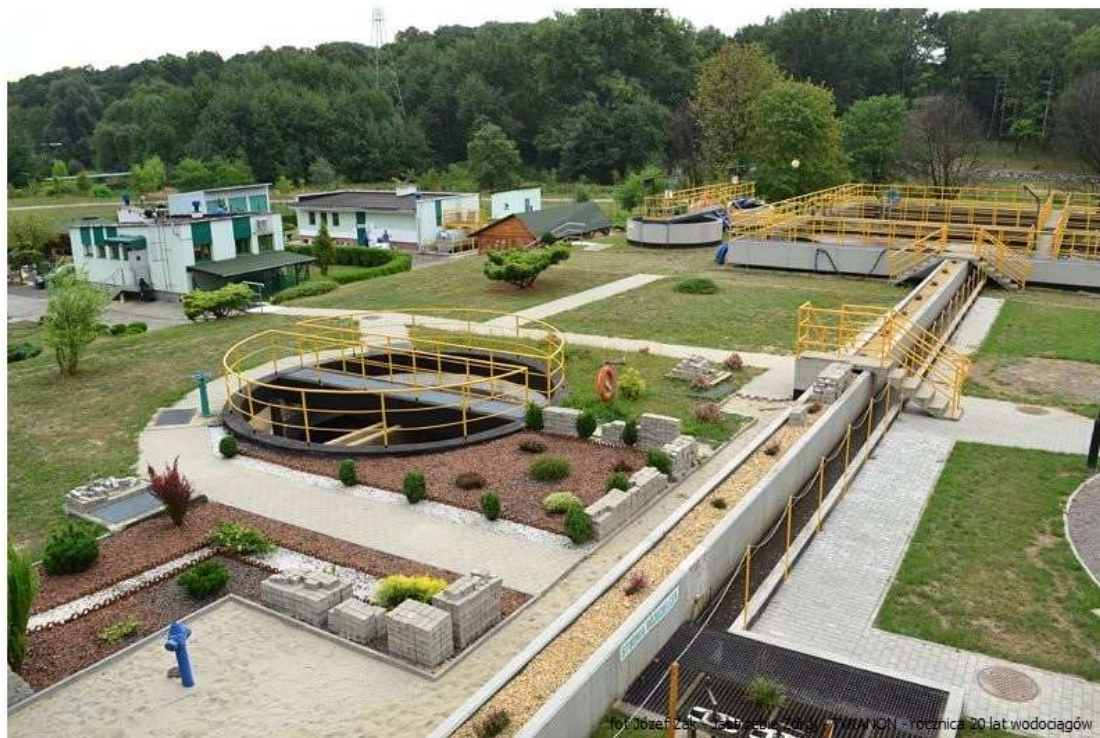
Oczyszczalnia ścieków Dolna 2013
