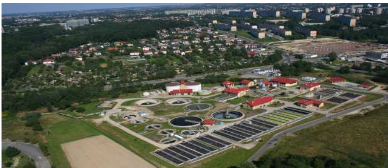
Oczyszczalnia Ruptawa „z lotu ptaka”
