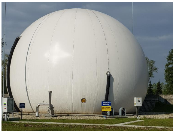
Zbiornik membranowy biogazu oraz stacja osuszania biogazu w OŚ Komorowice
