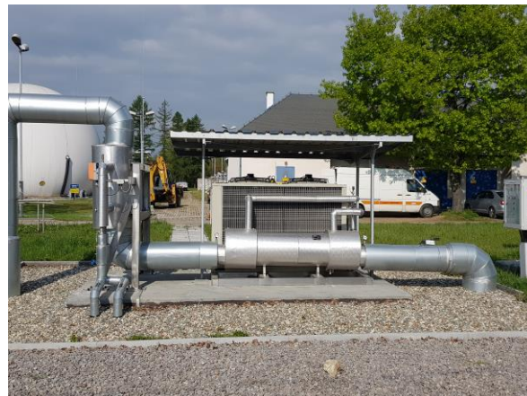
Zbiornik membranowy biogazu oraz stacja osuszania biogazu w OŚ Komorowice
